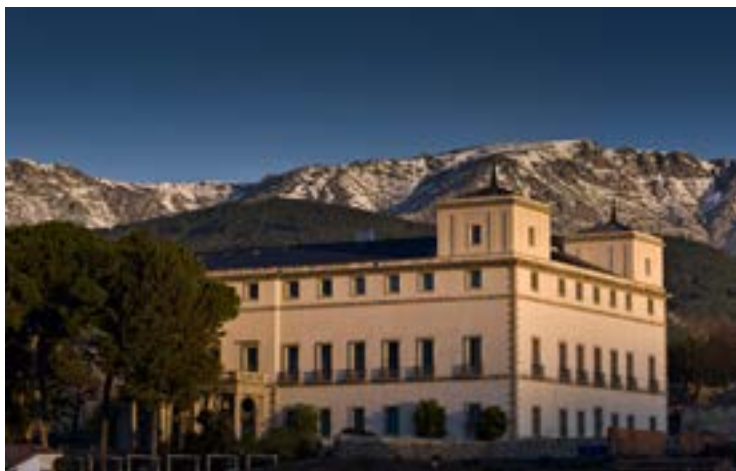
Fig. 17. Rehabilitación del Palácio de la Mosquera, Ávila (España). Arquitecto / EMA Espinosa de los Monteros & Arquitectos Asociados. Vista general Palácio reformado.
