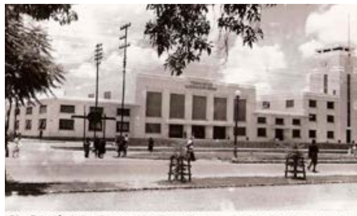
24.- Estación de los Ferrocarriles Nacionales.- San Luis Potosí, S.L.P. - 1942
