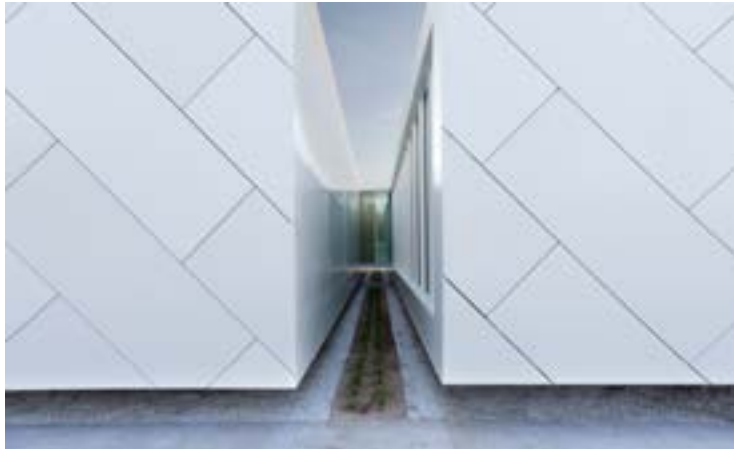
Fig. 1. Comisaría Policía Municipal de Alcobendas, Madrid (España). Arquitecto / EMA Espinosa de los Monteros & Arquitectos Asociados.
