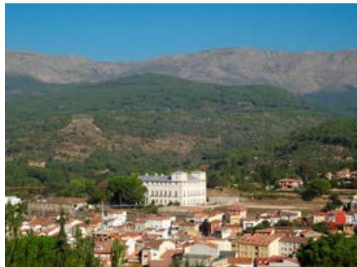
Fig. 12. Rehabilitación del Palacio de la Mosquera, Ávila (España). Arquitecto / EMA Espinosa de los Monteros & Arquitectos Asociados.
