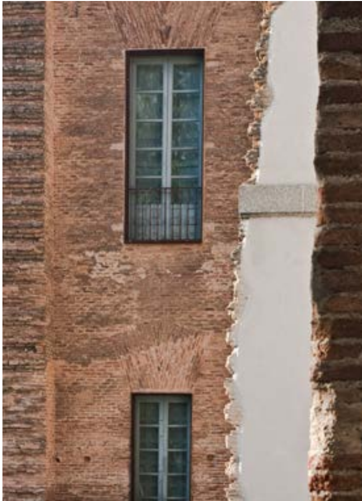
Fig. 15. Rehabilitación del Palacio de la Mosquera, Ávila (España). Arquitecto / EMA Espinosa de los Monteros & Arquitectos Asociados. Fachadas inacabadas.
