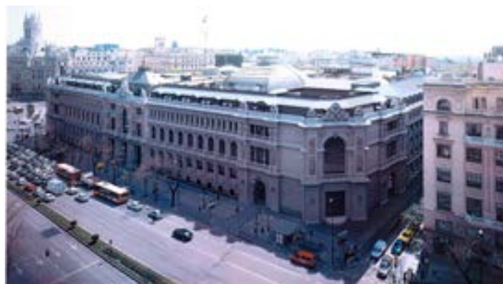
Fig. 4. Ampliación del Banco España de Madrid. Arquitecto / Rafael Moneo.
