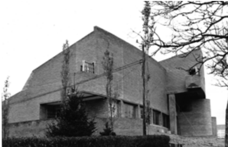
Fig. 24. Rehabilitación Colegio Mayor Argentino, Madrid (España). Arquitecto / EMA Espinosa de los Monteros & Arquitectos Asociados. Fotos originales de la construcción recién acabada.
