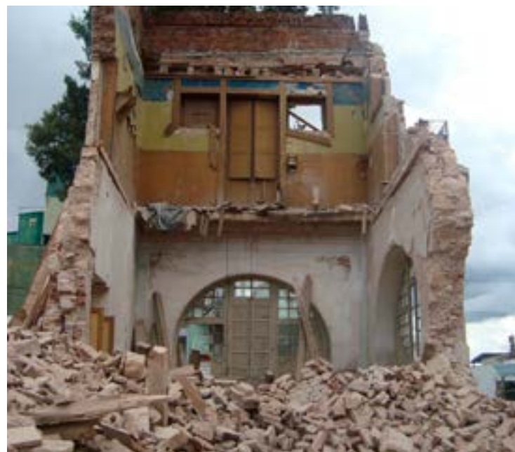
Fig. 2 y 3. Proceso de demolición de la vivienda familia Bravo, Morelia, Michoacán, 2011. Fotografías: André Aguilar.
