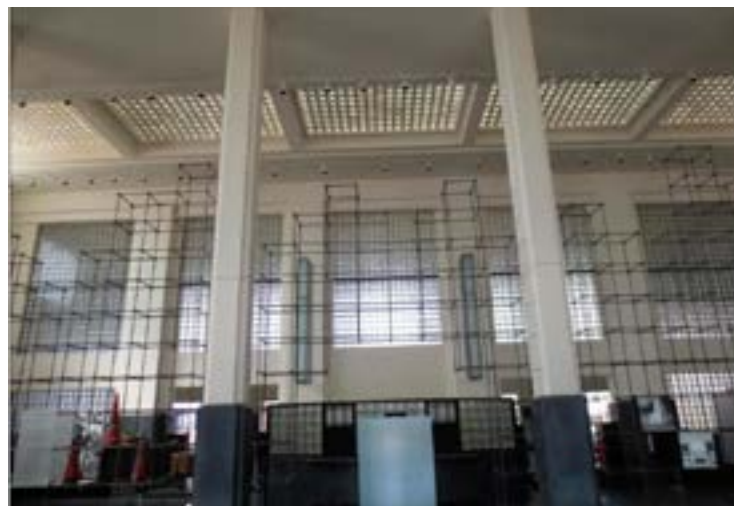
Fig. 11. Volumen nuevo, vestíbulo y circulaciones verticales. Fotografía: Jesús Villar.
